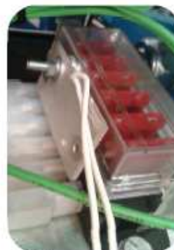
1 резистор по 5 Вт для каждого блока предохранителей
