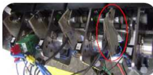
4 резистора по 5 Вт под рычажками
